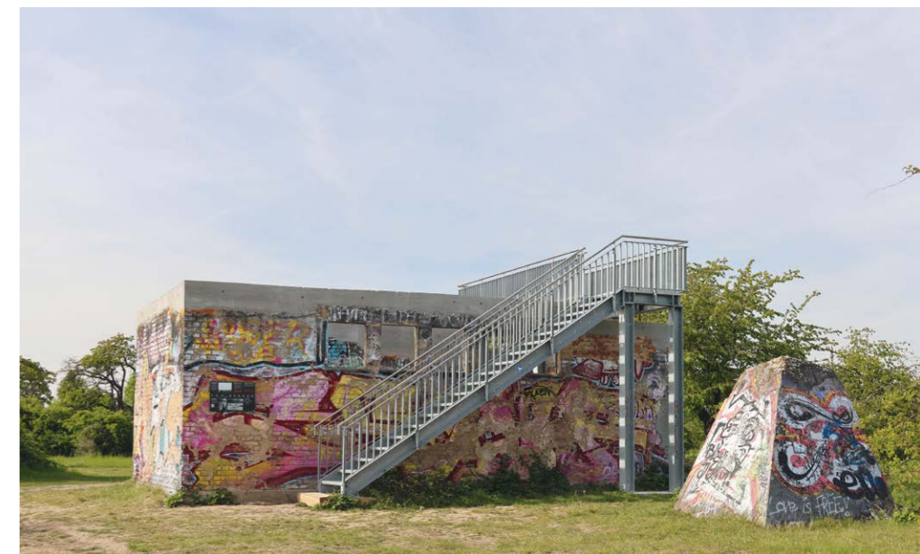
↑ Ruine des Sendehauses mit neu errichteter Aussichtsplattform
